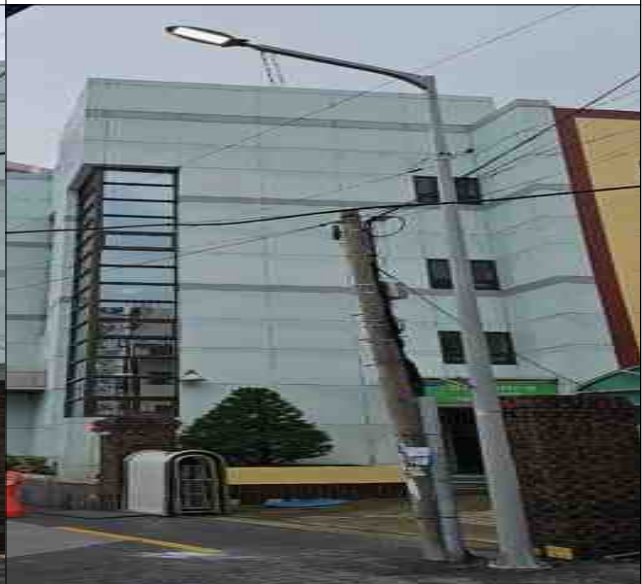
노후 가로등(FRP) 교체 후
