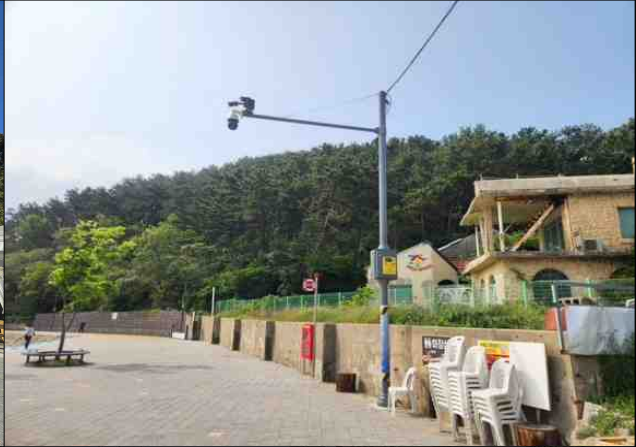
방법용 CCTV 신규 설치 후
