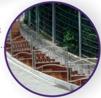
괴정동 K스타파크 주변 테코계단 설치
