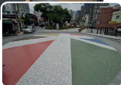
보행자 도로 조성
