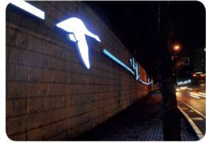
다대로 옹벽 디자인 개선
