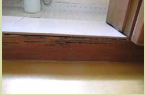
개조한 화장실 입구의 흰개미피해
